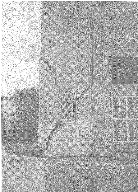
Fig. 6. Fallas Típicas de la Mampostería sin Refuerzo
